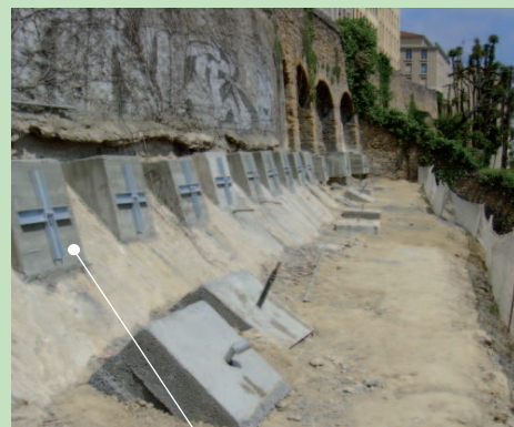
Chaque clou est terminé par une croix de Saint-André (pièce oblique formant un «X») permettant de concentrer les efforts.
