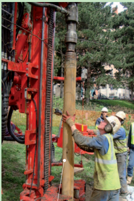
Forages verticaux permettant la pose d'instruments de mesures géologiques rue Magneval et rue des Fantasques (1er arrondissement).
