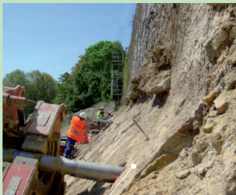
Forages horizontaux ayant permis de mettre en place seize clous d'ancrages à la base du mur des Fantasques pour en renforcer la structure.
